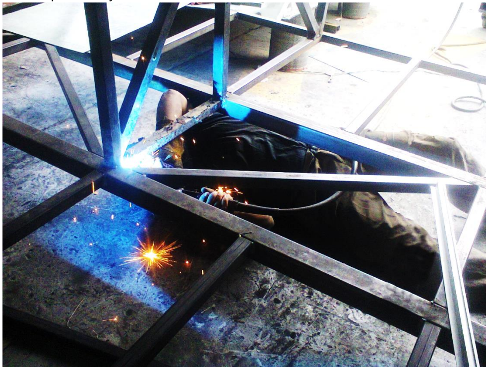
Reparación de estructura piso de cajuelas
